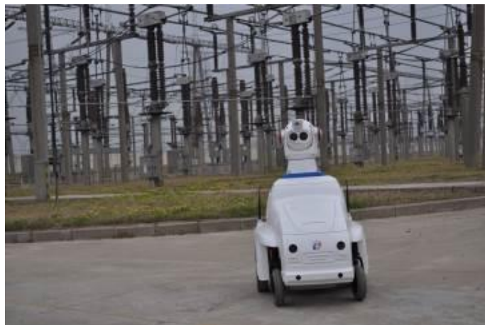
变电站巡检机器人
