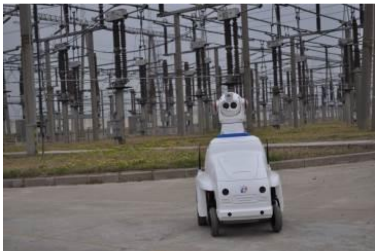
变电站巡检机器人
