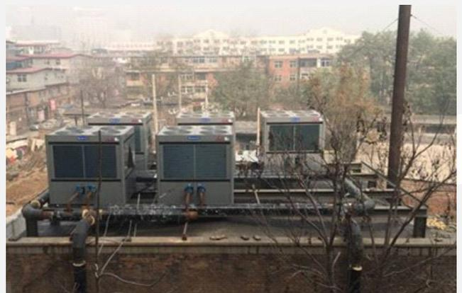
煤改电小区供暖热泵热水机
