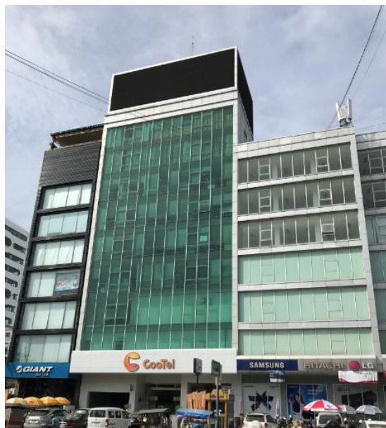
柬埔寨信威办公楼
