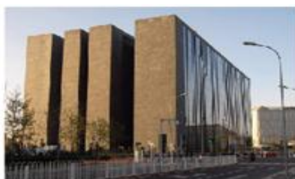
奥运数据中心
