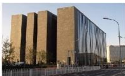
奥运数据中心
