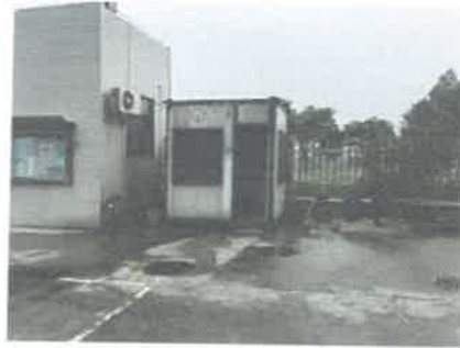
吸烟室、不锈钢围墙、水泥地面
