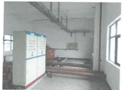
10. 工具房及水泵房 (3)
