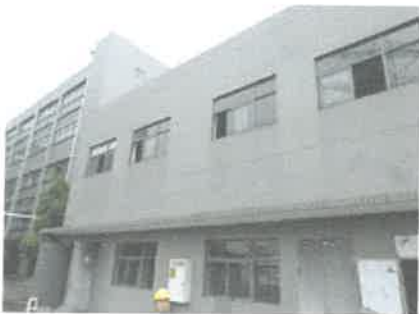
10. 工具房及水泵房 (1)
