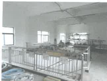
10. 工具房及水泵房 (2)
