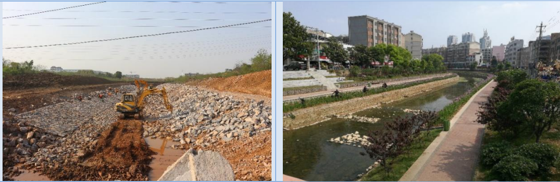
荆门竹皮河项目现场
