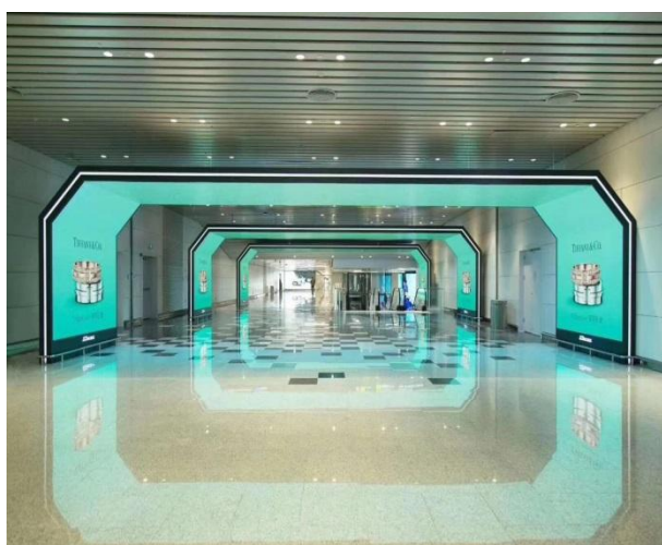
广州白云机场T2航站楼项目
