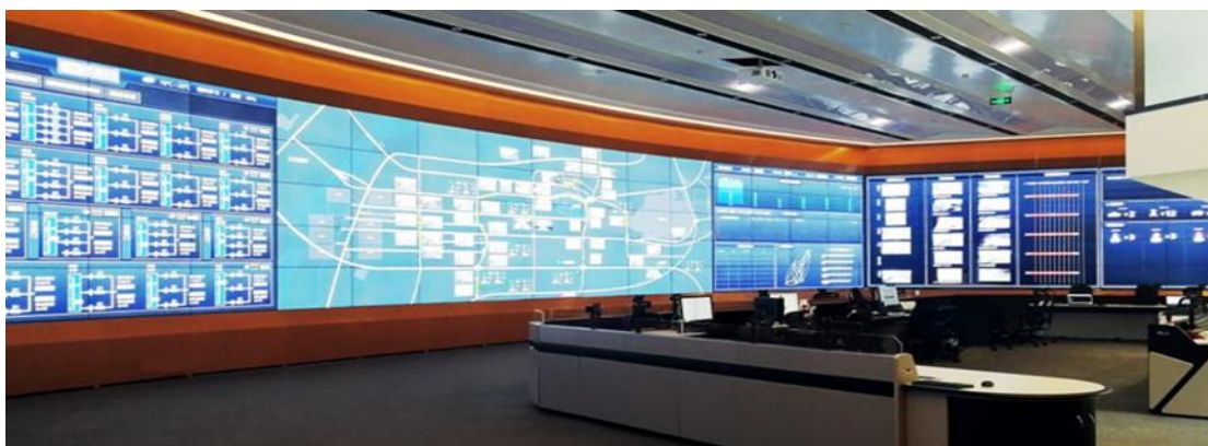
南京玄武湖隧道控制中心
