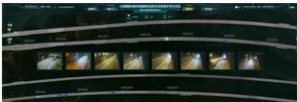
西汉高速秦岭隧道群项目
