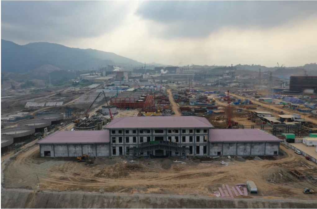
印尼镍资源项目建设现场
