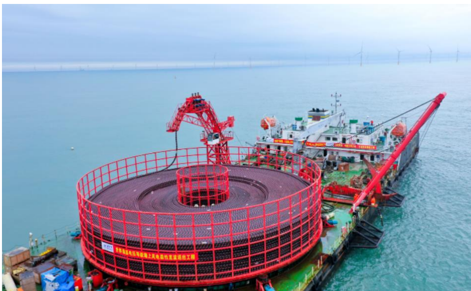
图 3-1：中天科技承制并敷设施工的±400 kV 直流海缆的顺利交付运营
