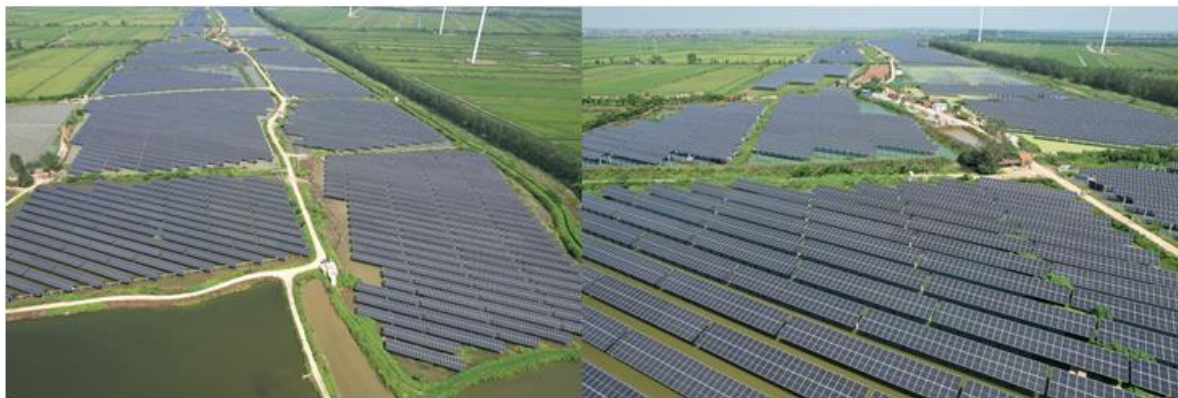
图 3-3：黄冈小池滨江新区 300MW 渔光互补发电项目（一期）
