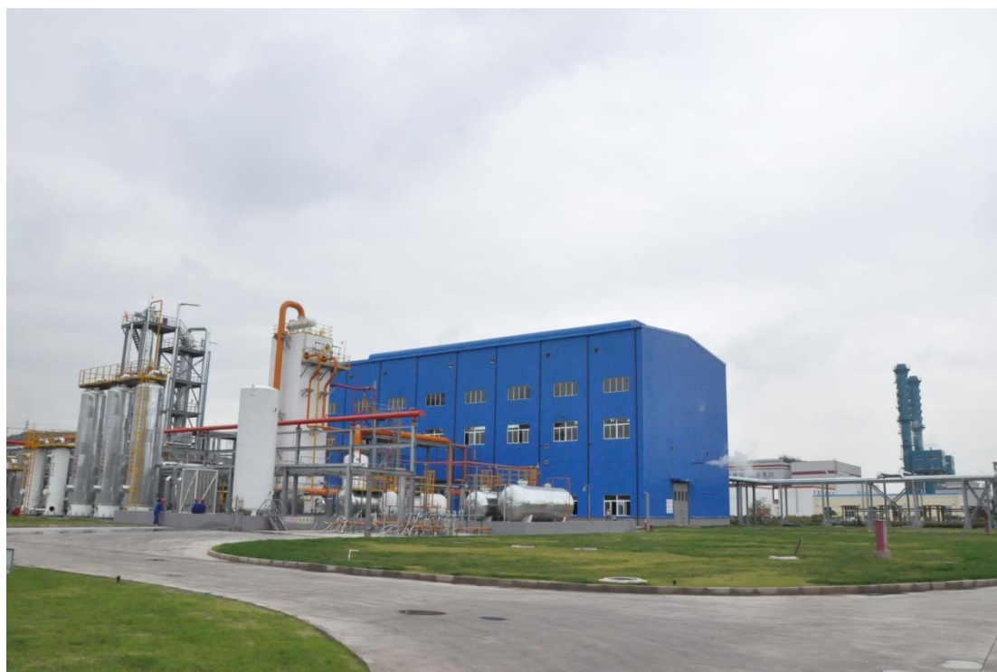
山西国新能源 50 万方/日 LNG 项目
