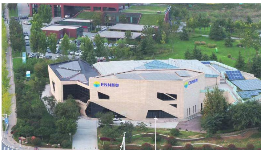
图 4：中德生态园综合能源项目
