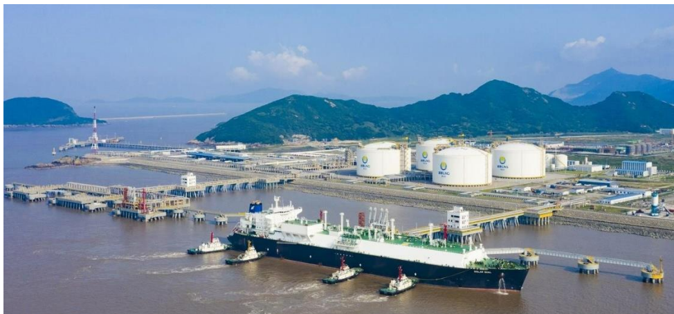
图 5：舟山 LNG 接收站
