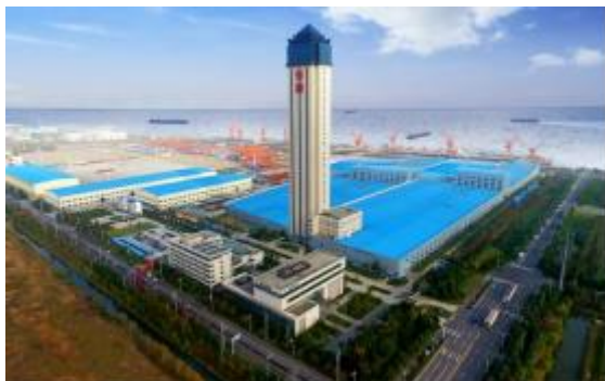
图 4 苏州常熟亨通国际海洋产业园
