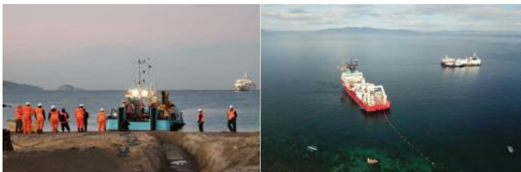
图 10 重大跨洋海缆通信系统项目建设
