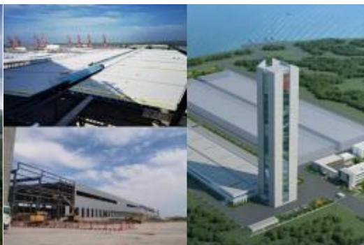
图 5 建设中的射阳生产基地
