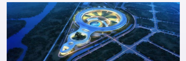
承建“怀柔区韧性城市燃气安全专项(一期)项目”
