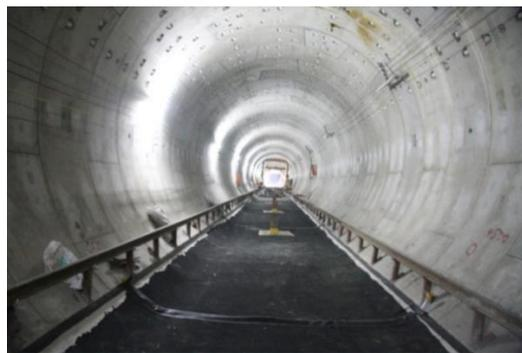
隔离式橡胶减振垫使用效果图
