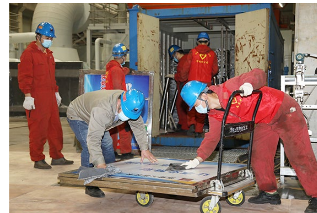
浙能工程志愿者更换破损围栏板，消除场地安全隐患
