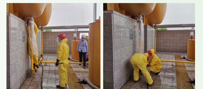
检修人员进行应急处置
