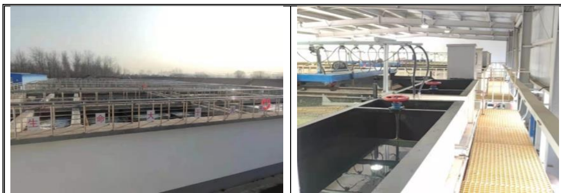
北京市大兴区凤河营闸河水水质强化站工程 (现场实景)
