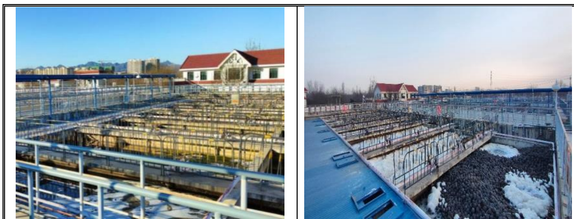
北京市顺义区赵全营镇再生水厂项目（现场实景）
