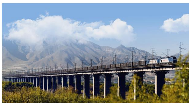
奥特迅功率融通装置应用于 X X 铁路 (国家级电气化重载铁路, 我国西煤东运大通道)
