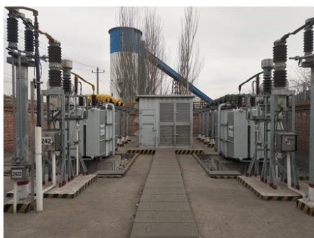
奥特迅27.5kV 5MVA铁路功率融通装置现场照片
