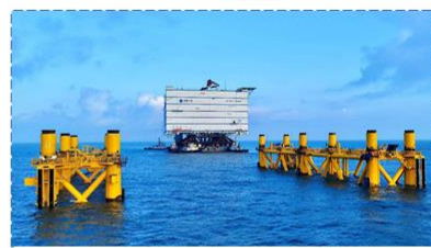
如东海上柔直工程换流站
