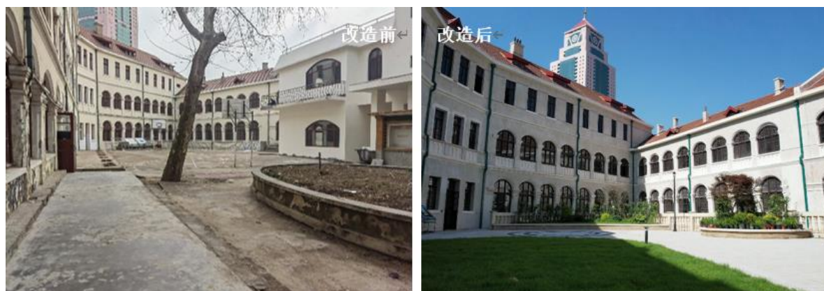
(圣心修道院修缮项目)
