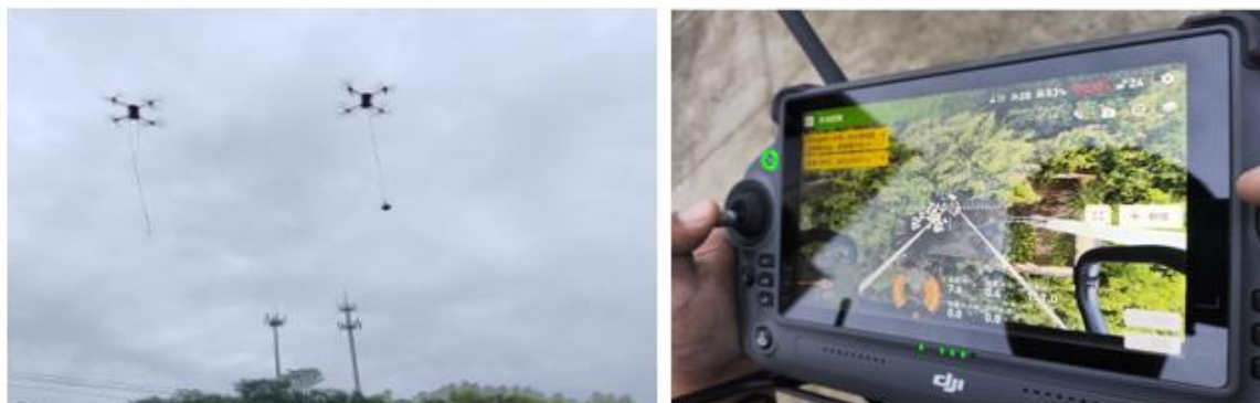
图 14：无人机吊装作业现场
