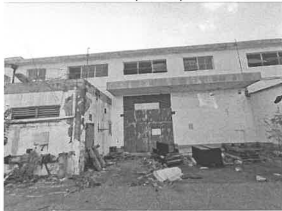
有证 9 幢(锅炉房)
