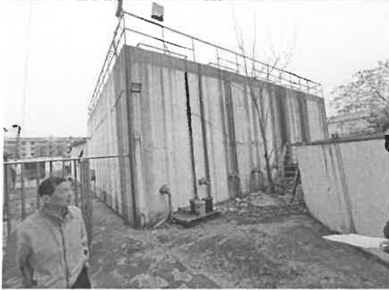
未见证 3 (污水处理间)
