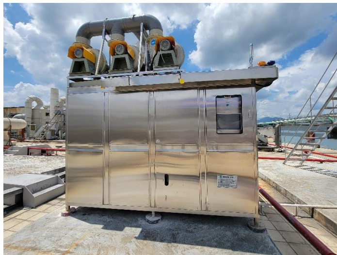
通过氨氮电解项目的实施，总氮排放大幅下降
