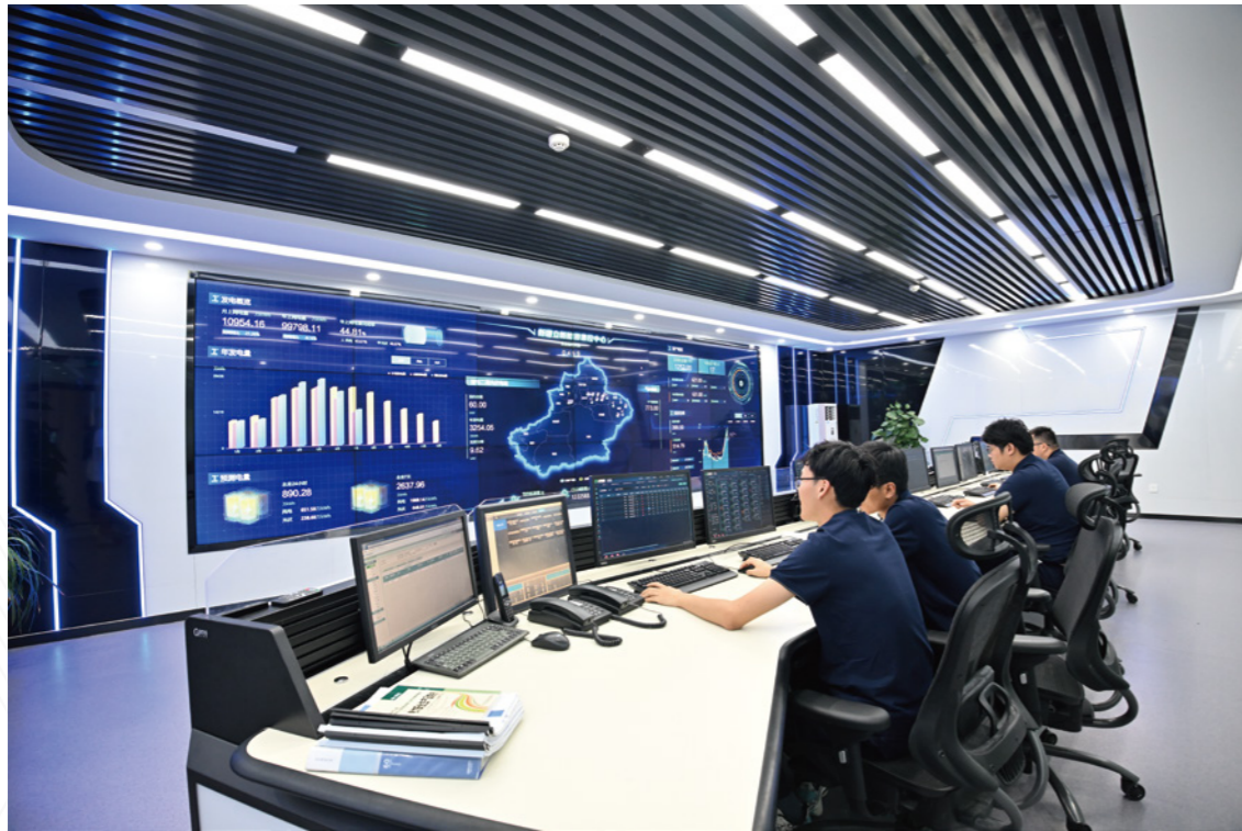
新能源智慧集中监控中心
