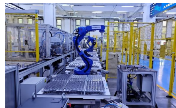
电液控换向阀阀芯柔性装配生产线
