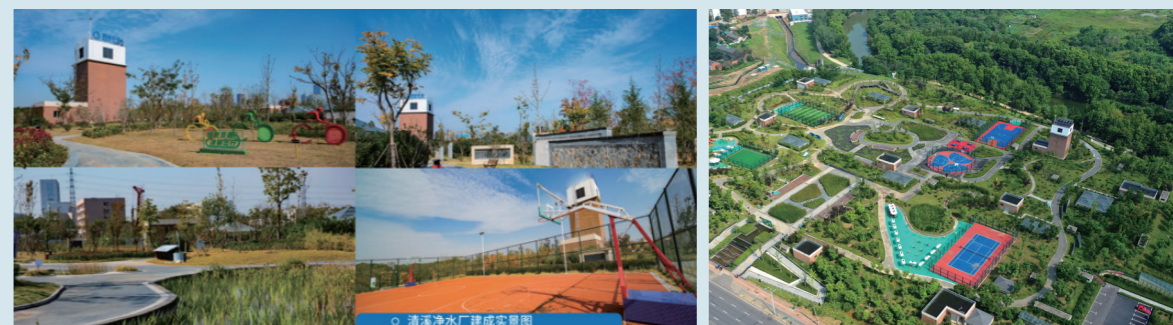
合肥市清溪净水厂
