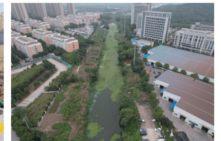
芜经开发区黑臭水体治理项目
