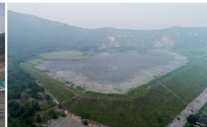
▲ 尾矿库修复全景
