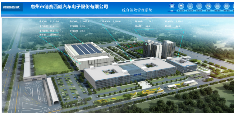
综合能效管理系统
