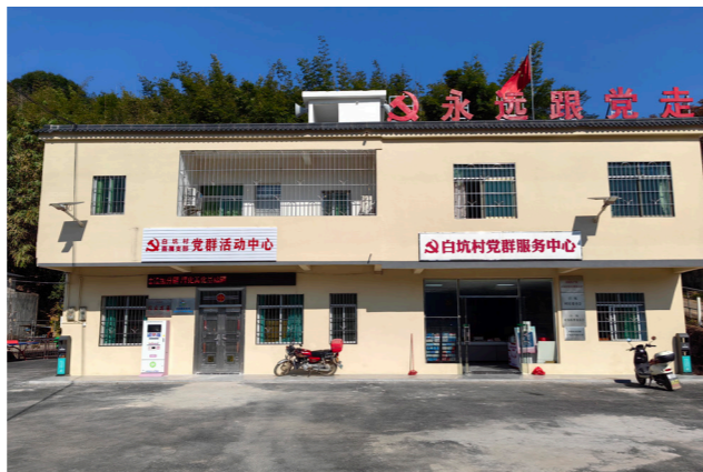
白坑村党群服务中心改造项目
