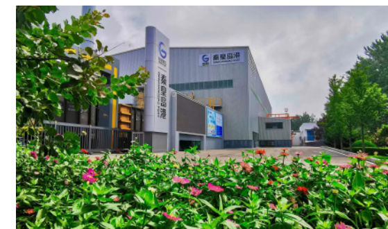
煤三期翻车机房外景
