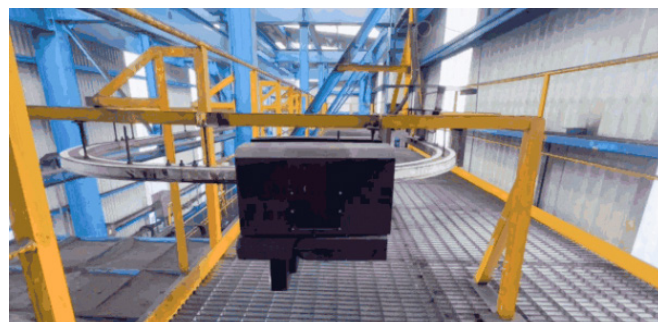
智能巡检机器人运行中
