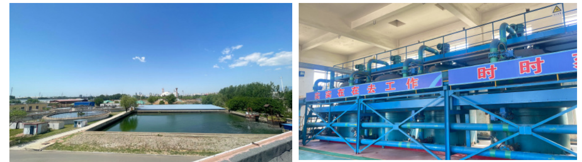
秦港股份中水厂内景
