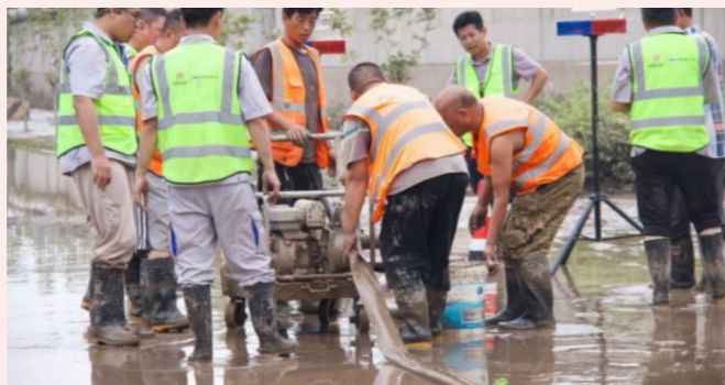
抢修抽水泵排污
