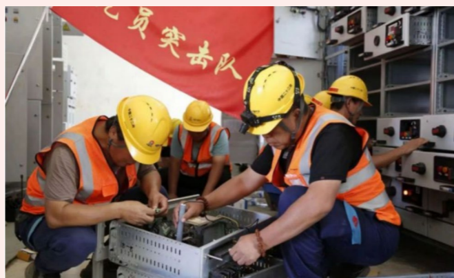
党员突击队在调试设备
