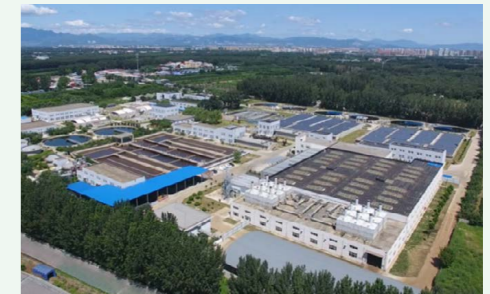
北京良乡污水处理厂项目
