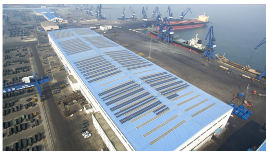
图注：辽港股份光伏设施
