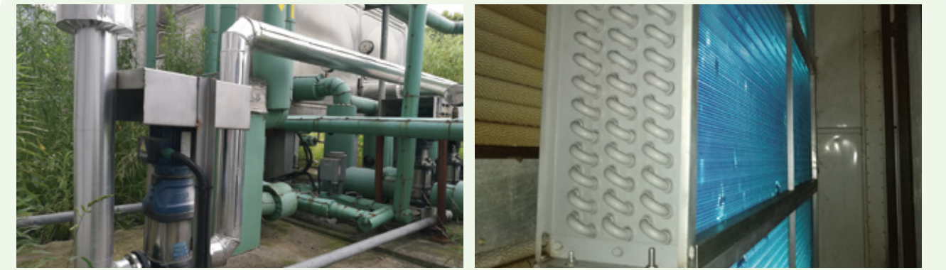
空压机余热回收项目改造
