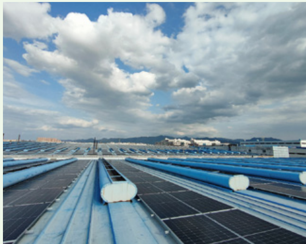
屋顶光伏板建设
