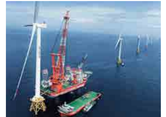
V20 平台国重项目率先号样机完成吊装
