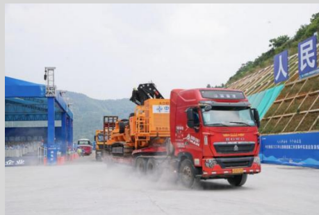
开展公路隧道施工突发事件应急演练
