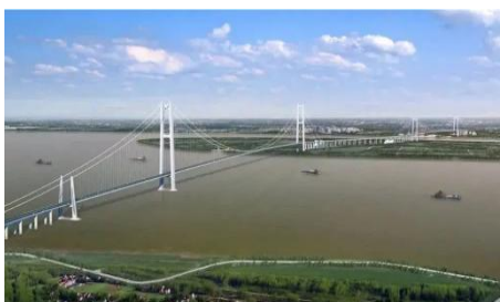
张靖皋长江大桥项目
