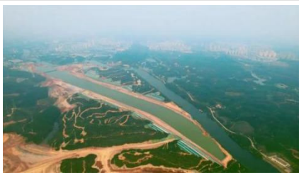
西部陆海新通道（平陆）运河工程
