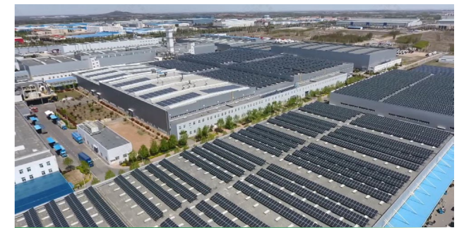
一汽解放青岛工厂光伏发电项目
