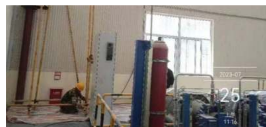
45MN快锻机液压站降噪改造施工
