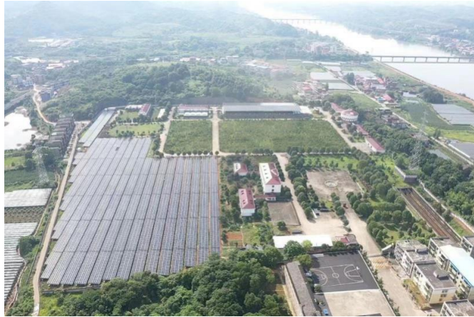
湖南耒阳自来水公司 5.16MW 分布式光伏项目
