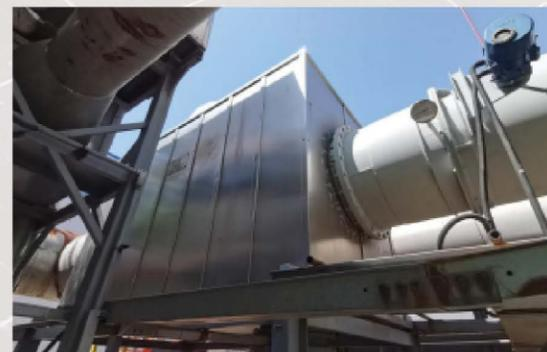
退火炉余热回收装置
