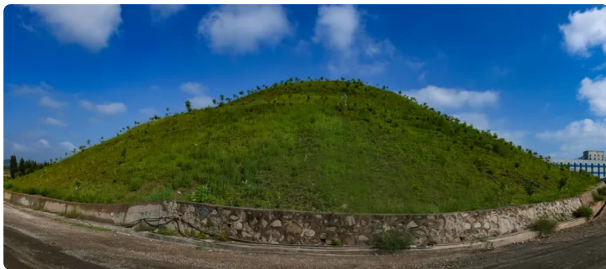
东庞矿挡矸墙
