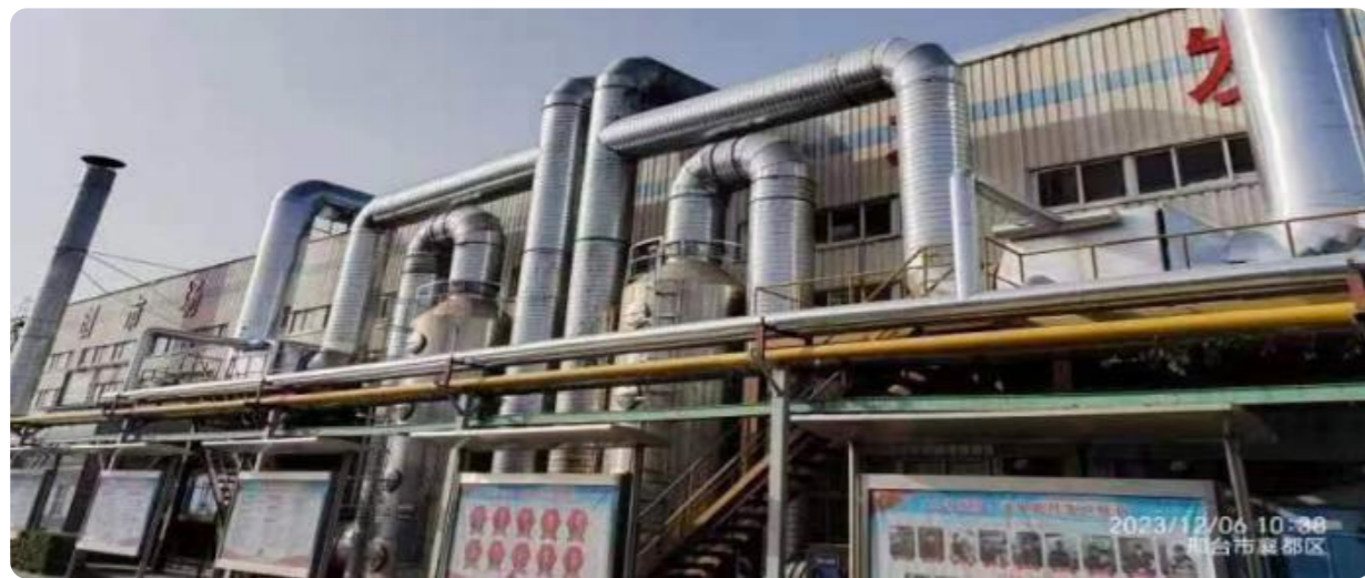
金牛玻纤采废气余热回收装置
