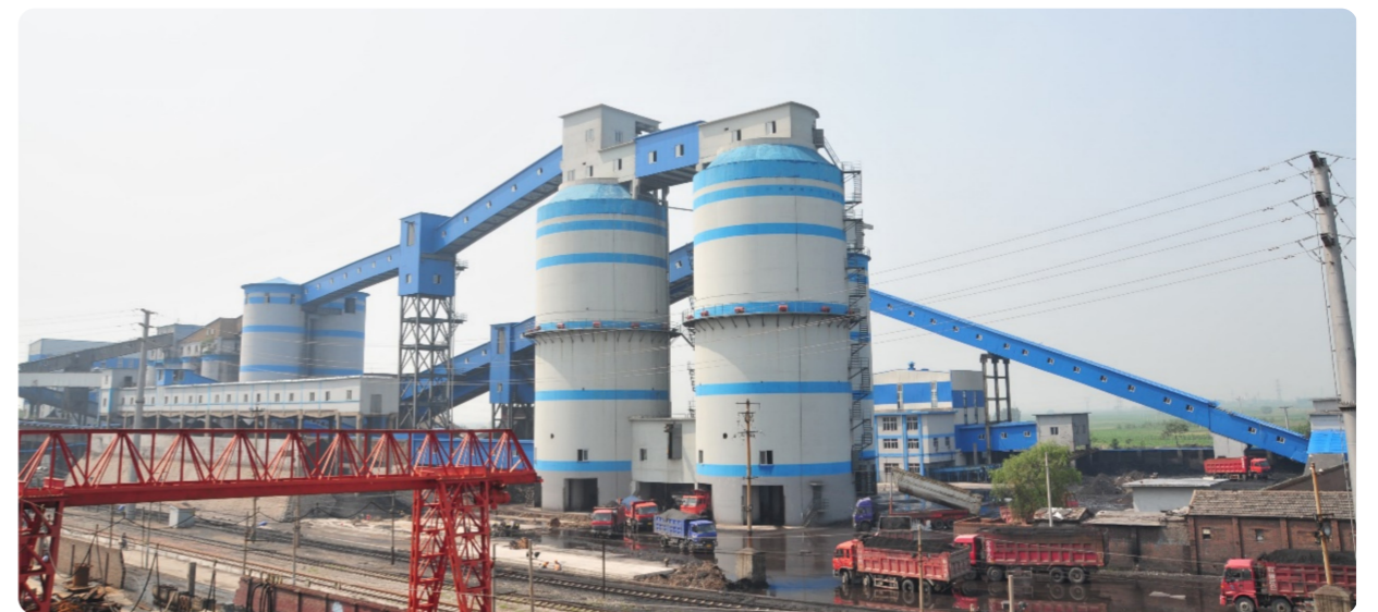
邢台矿原煤筒仓
