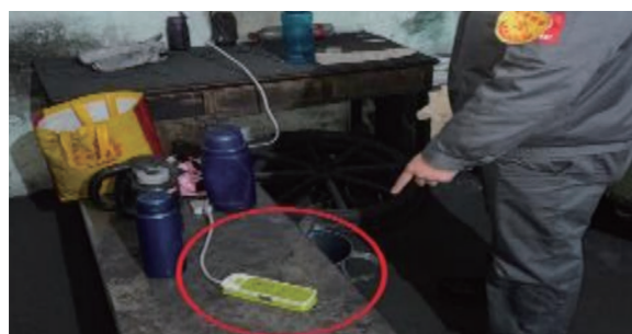
铸造工厂消防安全检查
