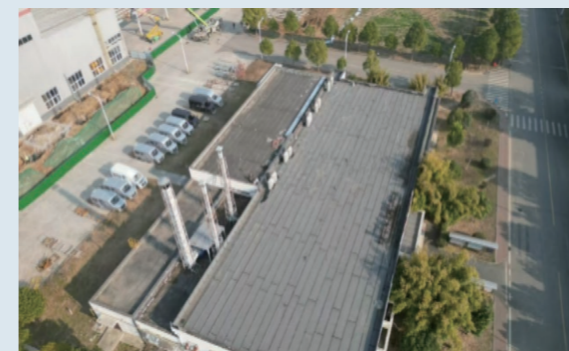
员工活动中心屋面安全检查
