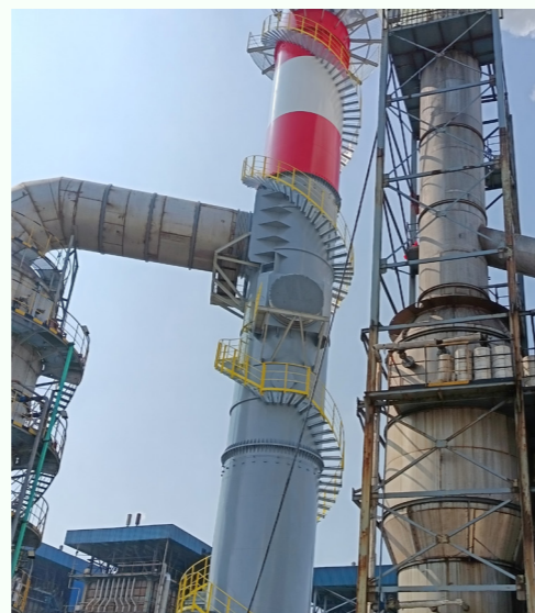
尾气锅炉改造
