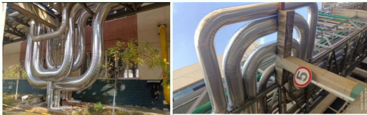
蒸汽主管道保温改造
