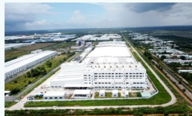
厂区景观面貌
