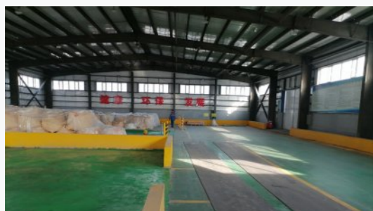
危险废弃物贮存库
