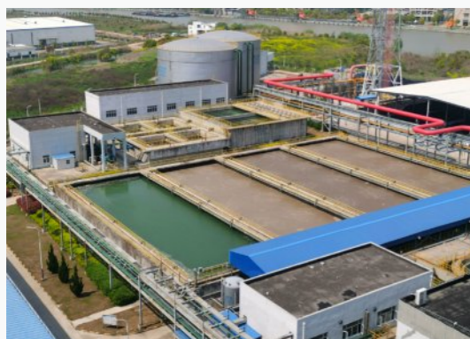
厂区污水处理设施
