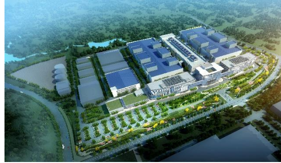
▲ 芯恩（青岛）集成电路有限公司电子信息产业园 套项目
