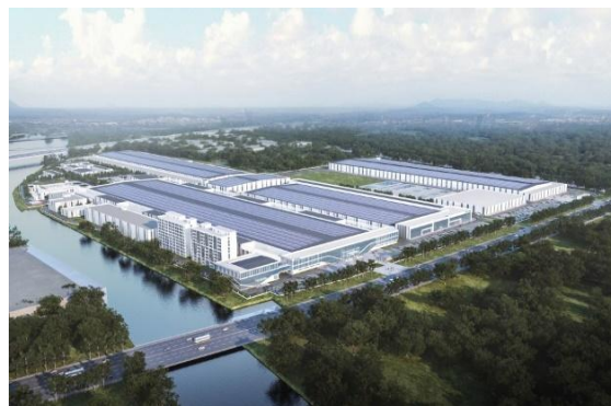
▲弘元新材料（徐州）有限公司光伏产业一体化制造基地项目
