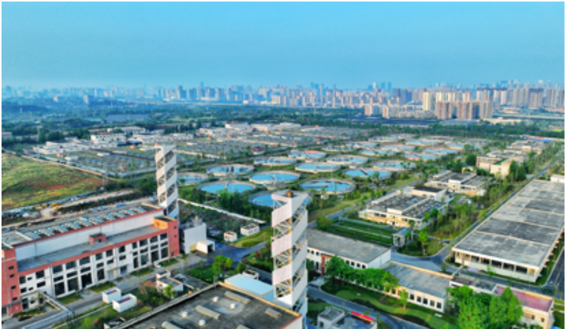
成都市第九再生水厂是国内一次性建成单体规模最大的污水处理厂之一
