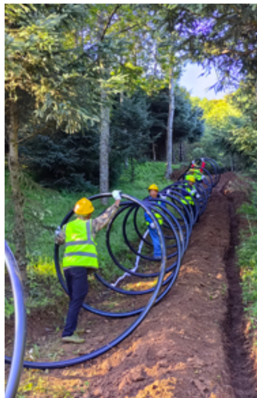
供水管道铺设
