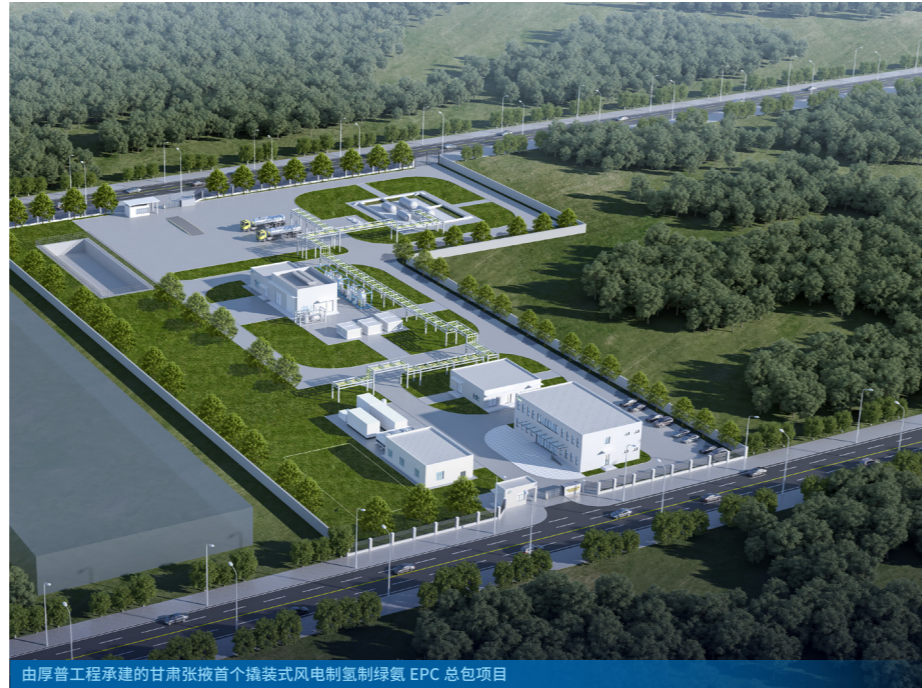
由厚普工程承建的甘肃张掖首个撬装式风电制氢制绿氨EPC总包项目
