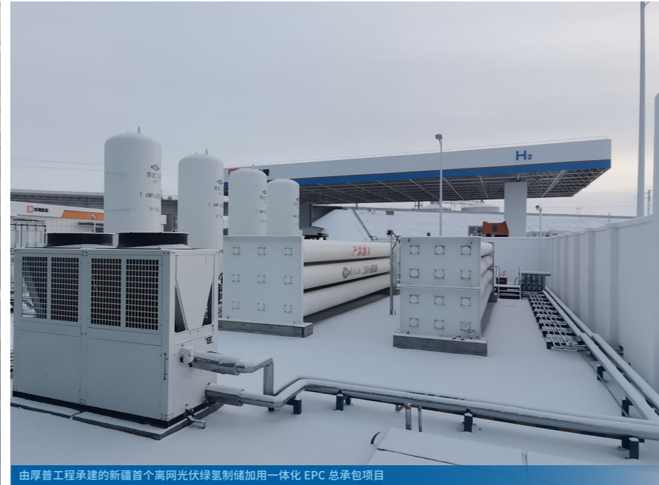
由厚普工程承建的新疆首个离网光伏绿氢制储加用一体化EPC总包项目
