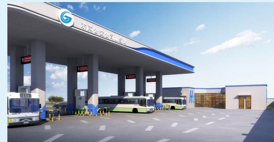
山东省首座固定加氢站,公交系统内第一座自建站——济南公交加氢站
