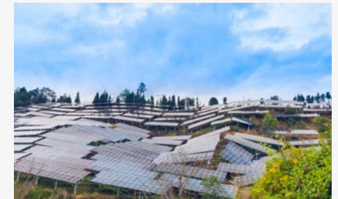
云南临沧 300MW 光伏复合项目现场图
