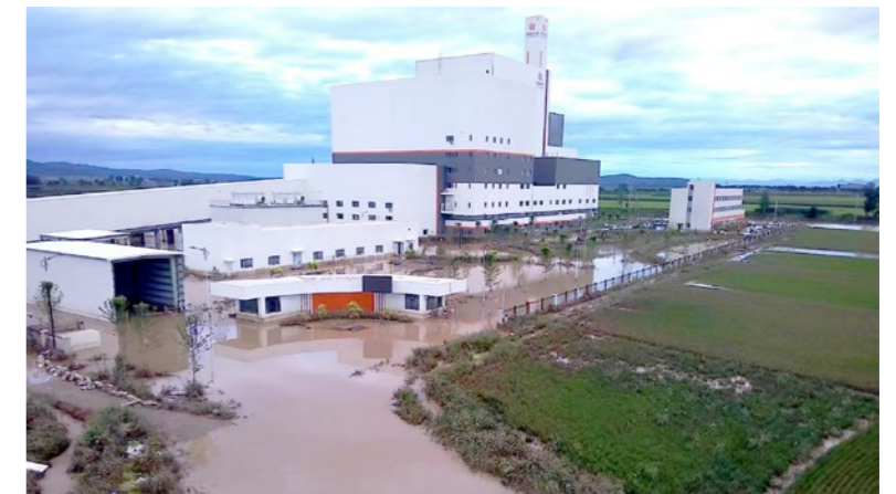
遭受洪水灾害侵袭的五常能源生态园
