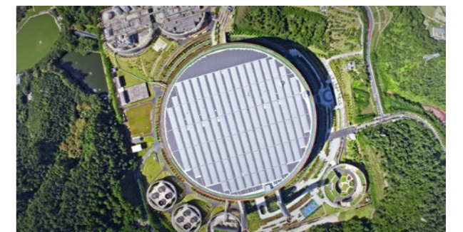
龙岗能源生态园电厂屋顶分布式光伏
