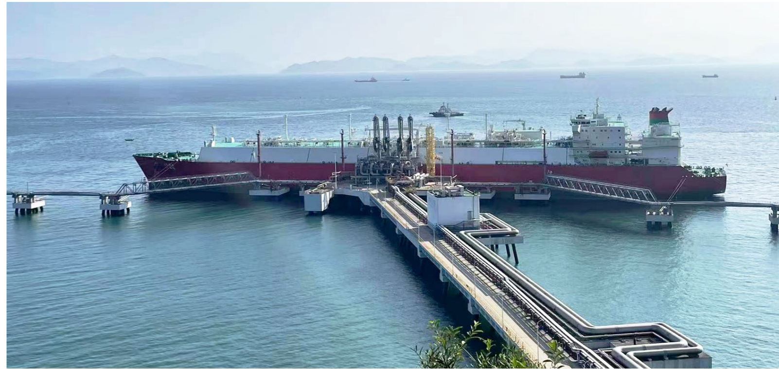
装载着深圳能源 2023 年第一船 LNG（液化天然气）现货的运输船顺利抵达深圳迭福 LNG 码头
